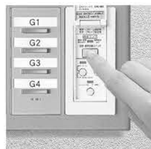
6 群組設定完成時，按下模式設定按鈕將系統切回正常模式。 (紅色LED熄滅)。
