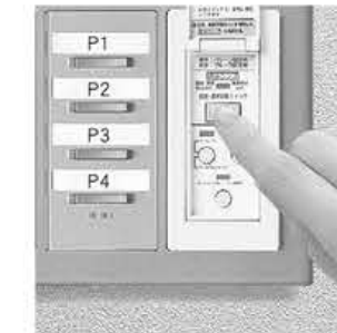
6 模式設定完成時，按下模式設定按鈕將系統切回正常模式。 (紅色LED熄滅)。
