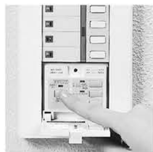
7 群組控制設定完成時，按下模式設定按鈕將系統切換回正常模式。(紅色LED熄滅。)
