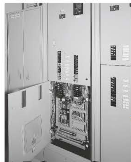
電驛控制盤內部
