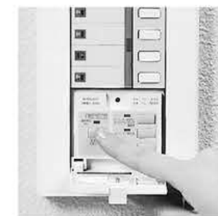
7 模式控制設定完成時，按下模式設定按鈕，將系統切換回正常模式。(紅色LED熄滅。)
