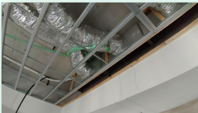
繞過風管安裝固定於正下方
