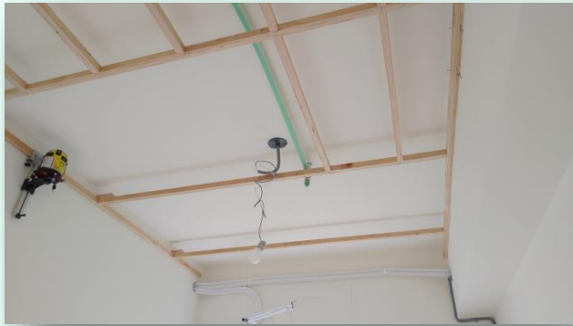
天花板與樓板距離僅10公分
