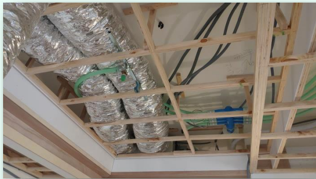
繞過風管安裝固定於正下方
