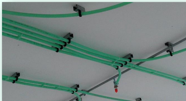
撒水管貼天花板固定 空間高度提高
