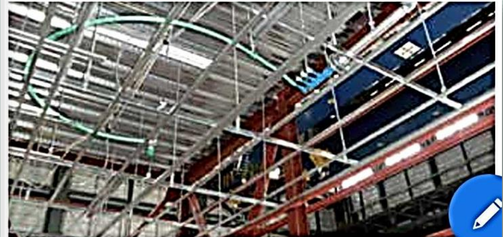
試験後、配管の機能損失・破損等がないことを確認。
