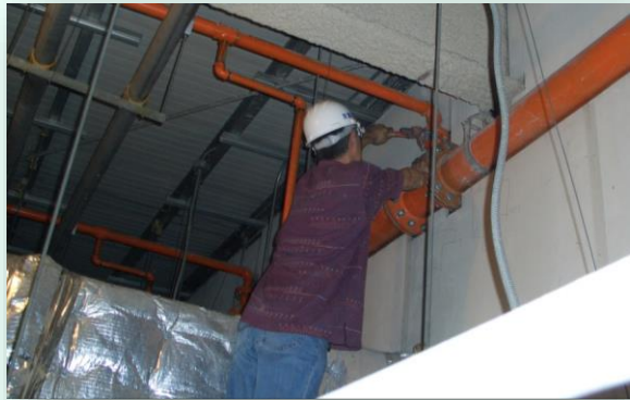
傳統鐵管配管修改 需長時間高空作業
