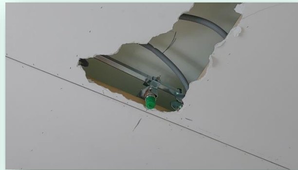
封版後小區域開孔後進行 撒水頭安裝
