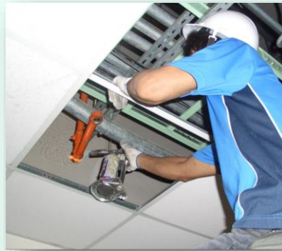
傳統鐵管配管修改 需動火作業
