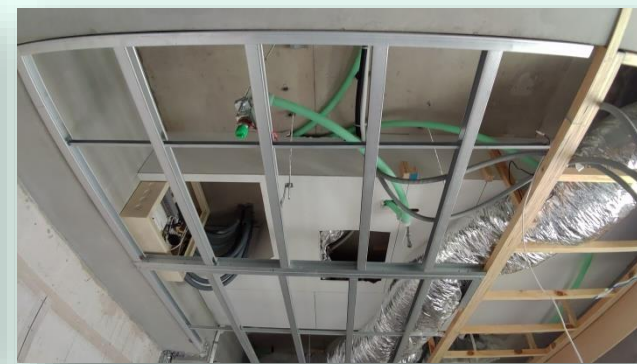
配合現場控制設備與燈具 安裝撒水頭
