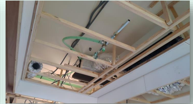
配合現場造型與燈具設備 排列整齊
