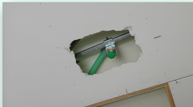
封版後小區域開孔後進行 撒水頭安裝
