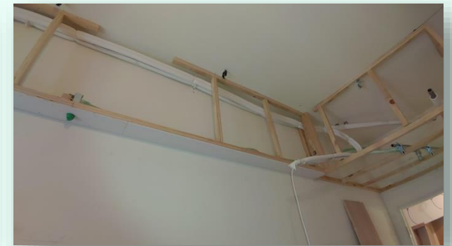
配合現場收納櫃安裝固定 狹小空間內
