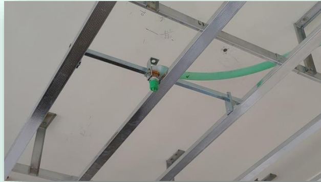
封輕鋼架方式也可固定 撒水頭
