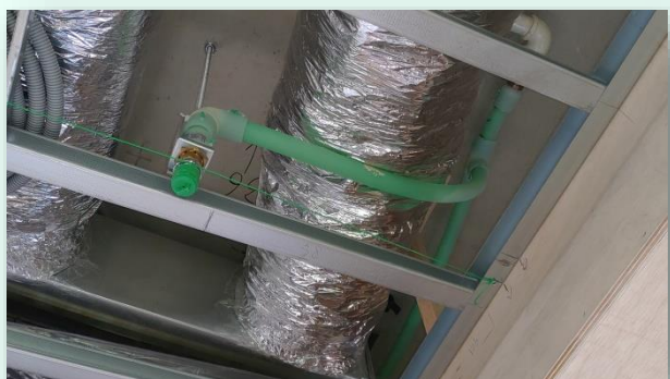
繞過風管安裝固定於正下方
