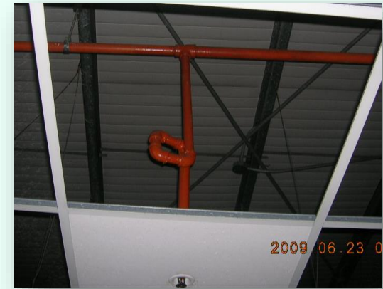
傳統鐵管配管修改不易 為求準確定位配管複雜
